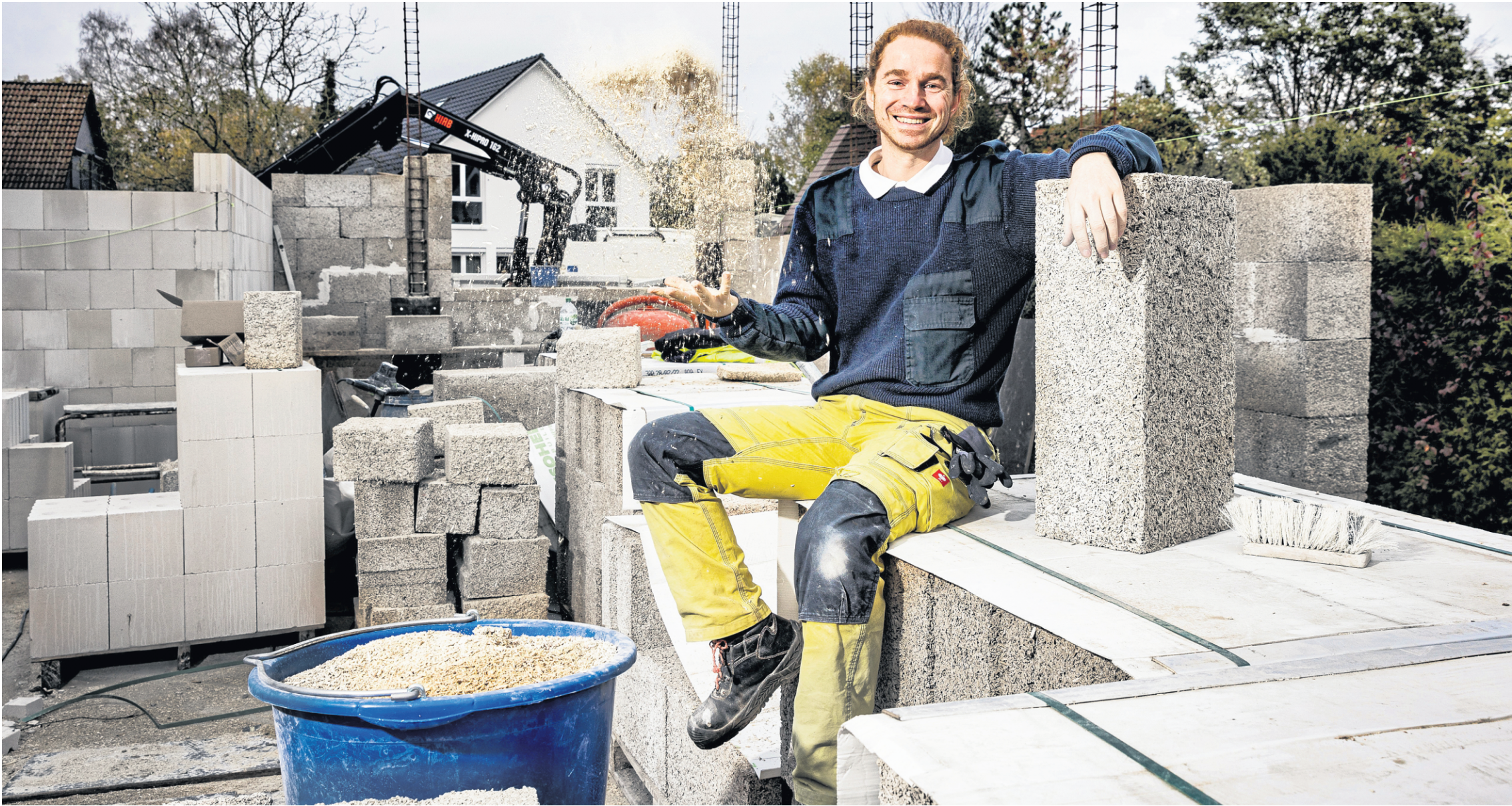
Der selbst ernannte Hanfingenieur Henrik Pauly baut in Lurup ein Wohnhaus aus Hanfsteinen. ROLAND MAGUNIA
